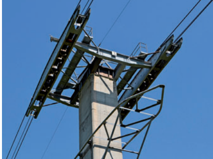
Auch die Masten werden nach 50 Jahren ersetzt.
