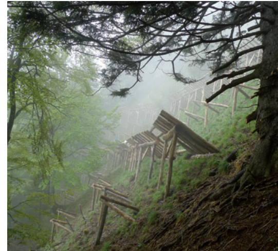
Schutzbauten am Zillstock. Schneerechen gegen Lawinanriss und Dreibeinböcke zum Schutz der gepflanzten Jungbäume.
